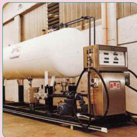
Dystrybutor GPL jest głównym urządzeniem, które powstało z myślą o tych rejonach, w których brak jest stacji GPL. Instalator zostaje obarczony tylko kosztem transportu i podłączenia elektrycznego, całość urządzenia jest gotowa do użycia zaraz po napełnieniu gazem. W razie braku podłączenia elektrycznego przewidziano również funkcjonowanie z silnikiem na GPL. Konstrukcja jest typu modułowego, zbiornik w zależności od potrzeb na 3000 lub 5000 litrów lub na życzenie klienta o innej pojemności.
